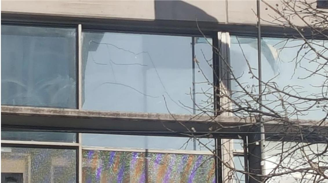
Se recomienda abrir las fisuras y sellarlas, posteriormente retirar todo revoque de recubrimiento que se encuentre en condiciones de desprendimiento. Posteriormente revocar los sectores reparados con concreto y finalmente pintar integralmente la fachada con todos sus elementos constitutivos y sus partes componentes.
